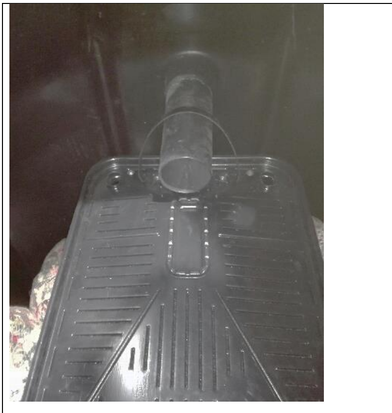
Kuva 15. Jakoaltaan asennus BioPlus -puhdistamon sisälle.
