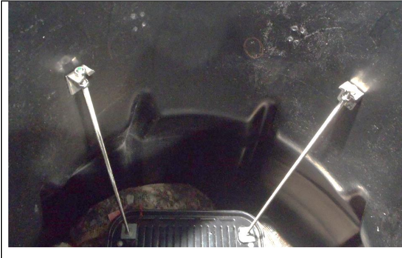
Kuva 17. Jakoaltaan kierretankojen kiinnitys huoltokaivoon.
