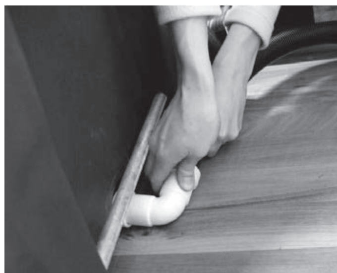
2. Desconexión de la manguera de desagüe
