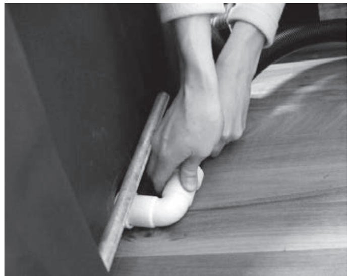
2. Отсоединение дренажного шланга
