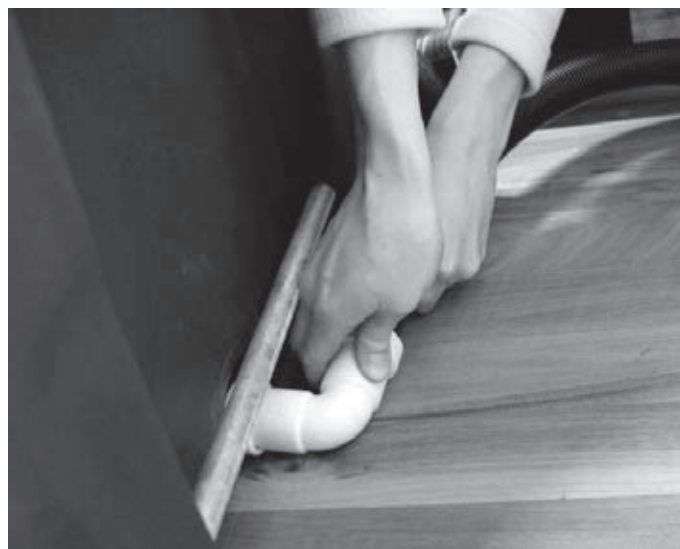
2. Démontage du tuyau d'évacuation
