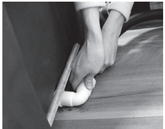
2. Odpojení odtokové hadice
